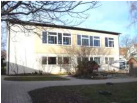
Auch von außen renovierungsbedürftig
