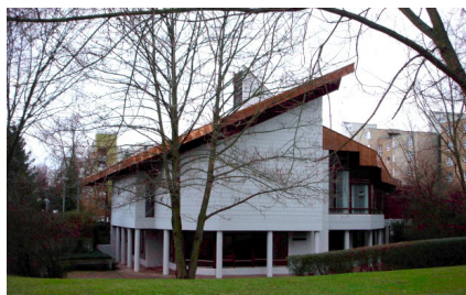
Gemeindezentrum West (GZW)
