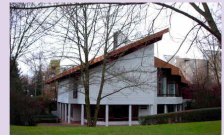
Gemeindezentrum West (GZW)
