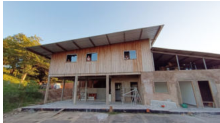
Unser Mitarbeiterhaus ist bald fertig. Im OG sind die ersten Mitarbeiter schon eingezogen. Zurzeit wird das EG ausgebaut.
